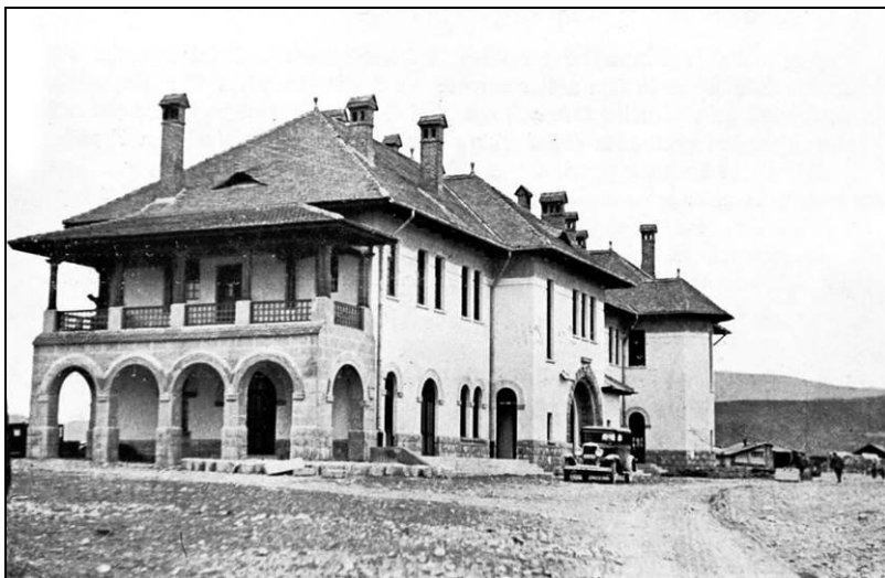
Bodola: az állomás épülete
