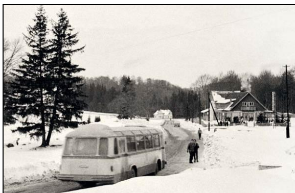
1967: A pojánai út építése (Gruia Hilohi)
